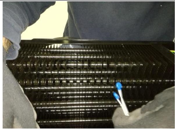
**9.** Die Kabel mit Schellen am Verdampfer befestigen.
