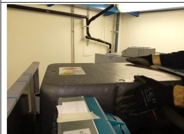
**16.** Den Sicherheitsriemen an der Schutzhaube schließen.
