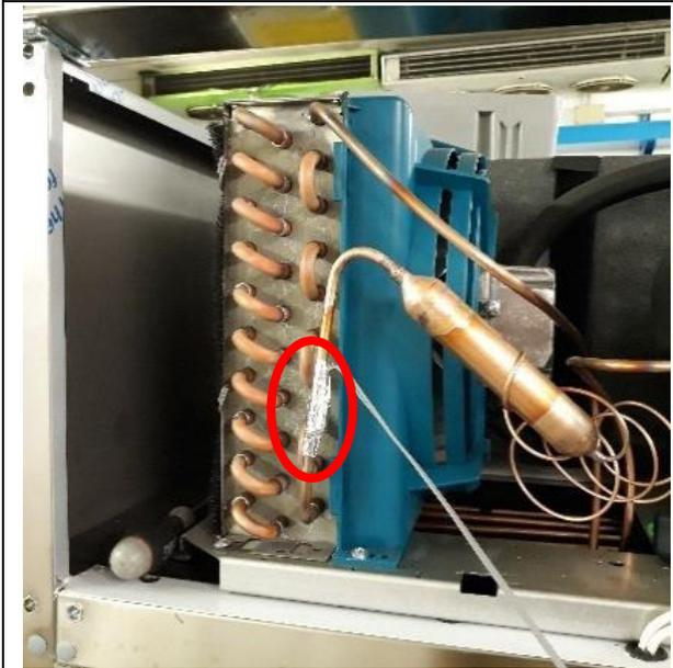
8. Die Schellen befestigen und den Fühler an der Platine anschließen.
