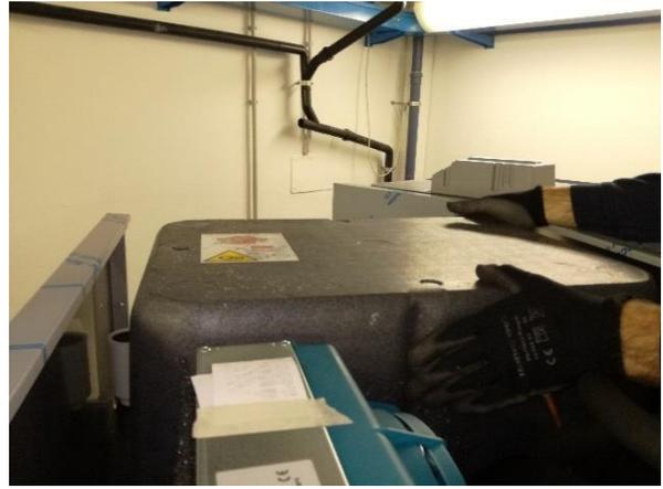
**15.** Den Sicherheitsriemen an der Schutzhaube schließen.
