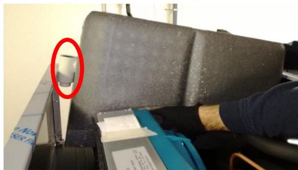
5. Die Schellen zur Blockierung der Kabel abschneiden.
